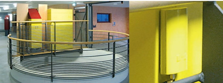
Farblich angepasste Sektorantenne in einem Parkhaus
