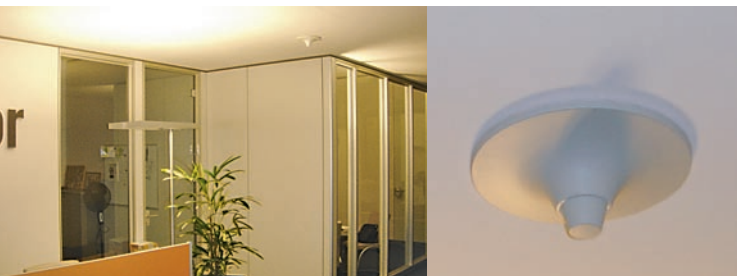
Deckenmontage mit Rundstrahlantenne
